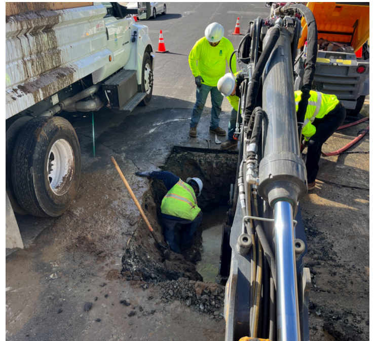
Diablo Water District realiza todas las reparaciones de la tubería principal de agua y la línea de servicio internamente.
